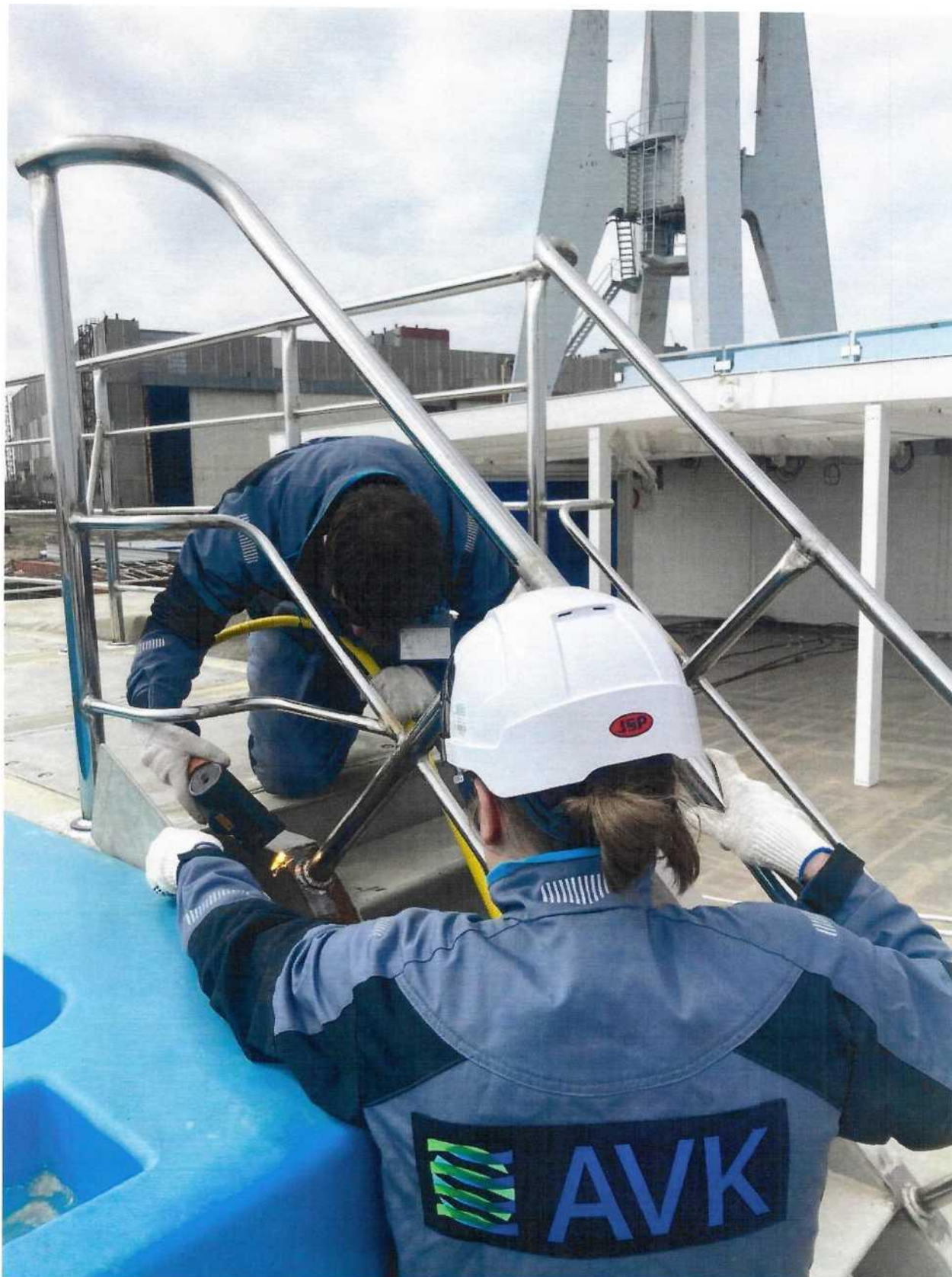
Фото 7. Процесс очистки биметаллических пластин оснований леерных ограждений;
