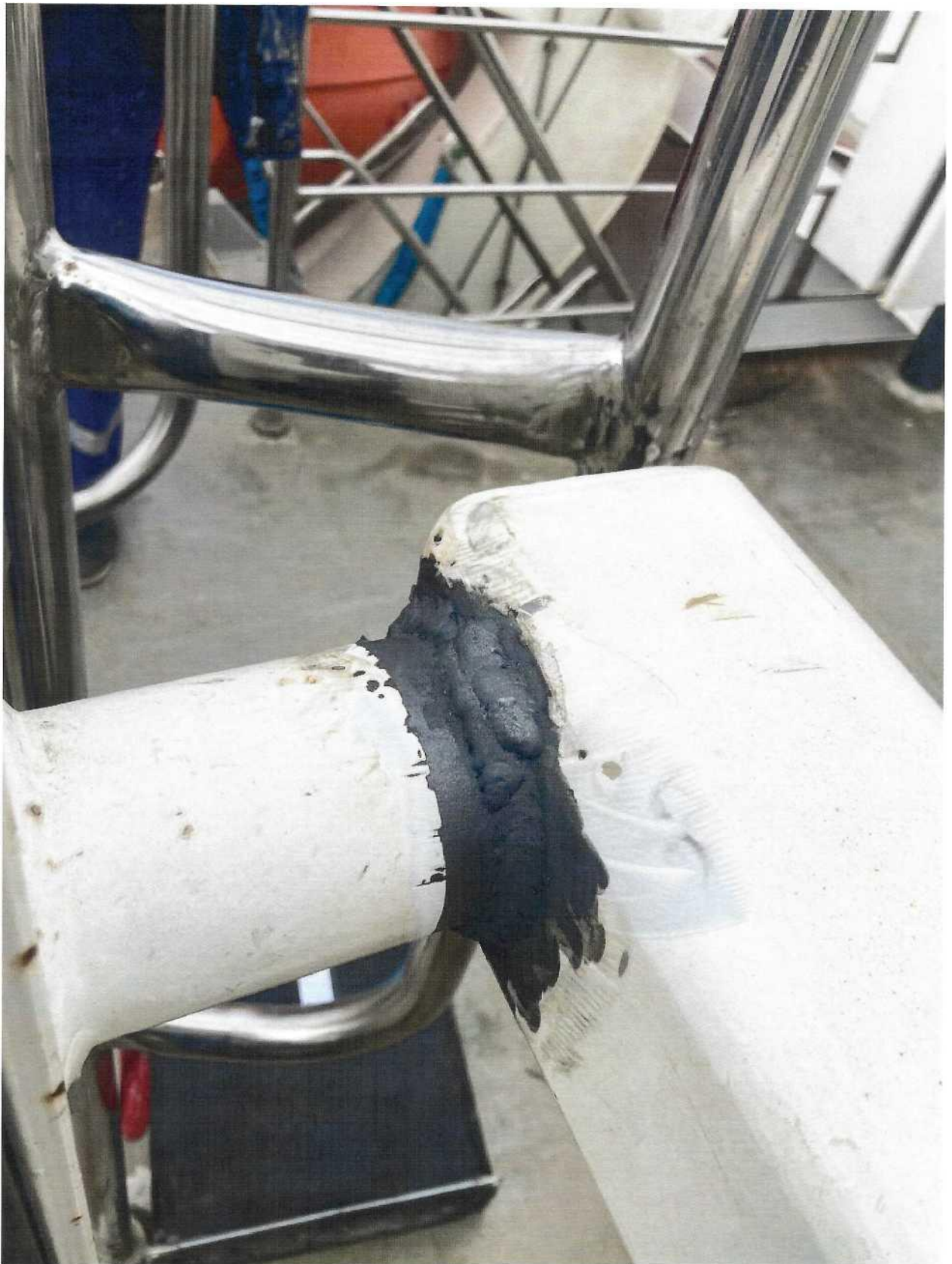
Фото 13. Результат очистки сварного шва. Материал СтЗ. Вид загрязнения - ржавчина и двухкомпонентный эпоксидный ЛКМ.
