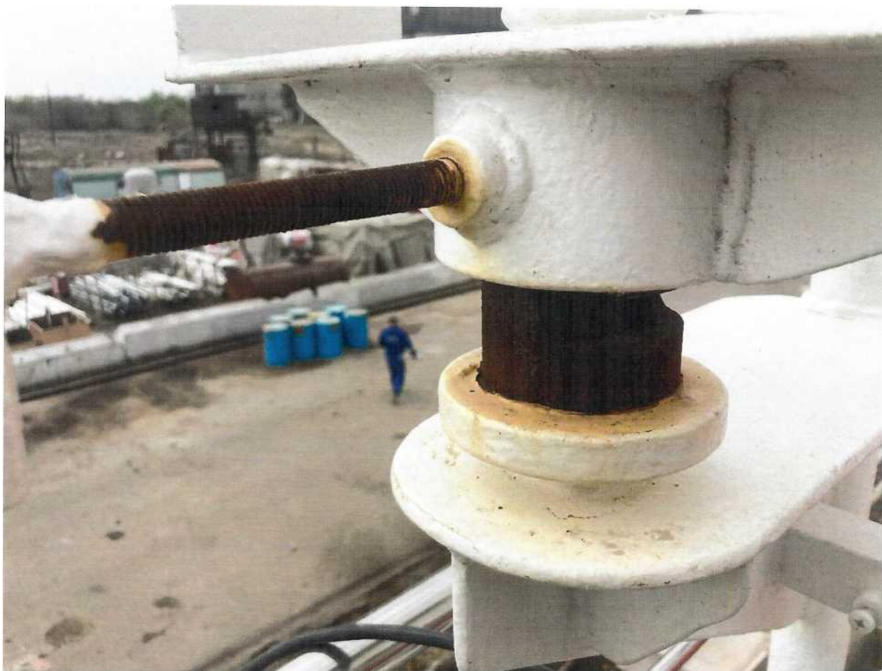
Фото 14. Исходный вариант загрязнения конструкции. Материал СтЗ. Загрязнение ржавчиной, в том числе резьбового соединения, также двухкомпонентный эпоксидный Л КМ, поражённый ржавчиной.
