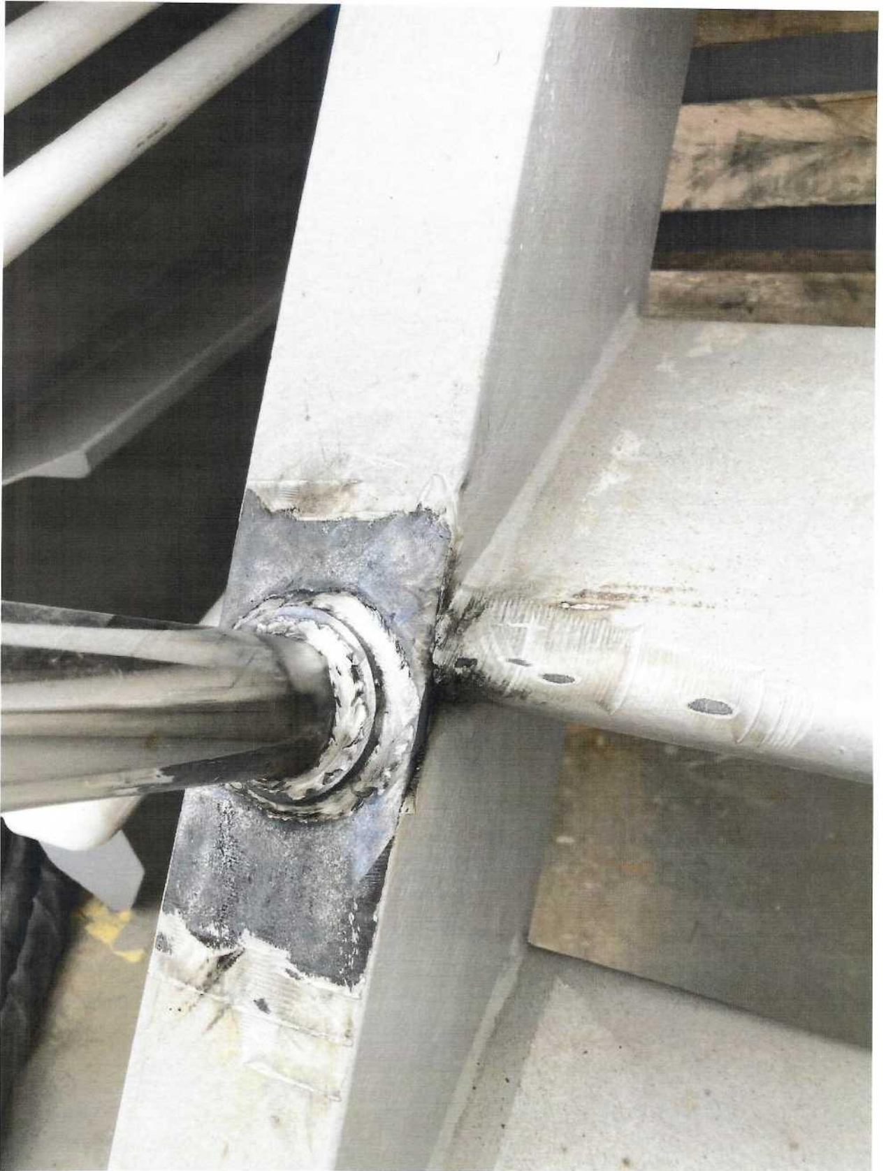
Фото 9. Результат очистки биметаллических пластин оснований леерных ограждений;
