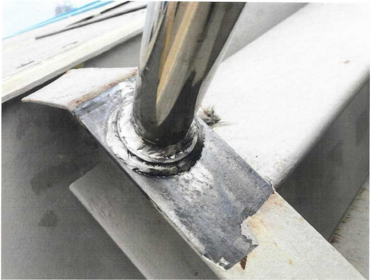
Фото 8. Результат очистки биметаллических пластин оснований леерных ограждений;
