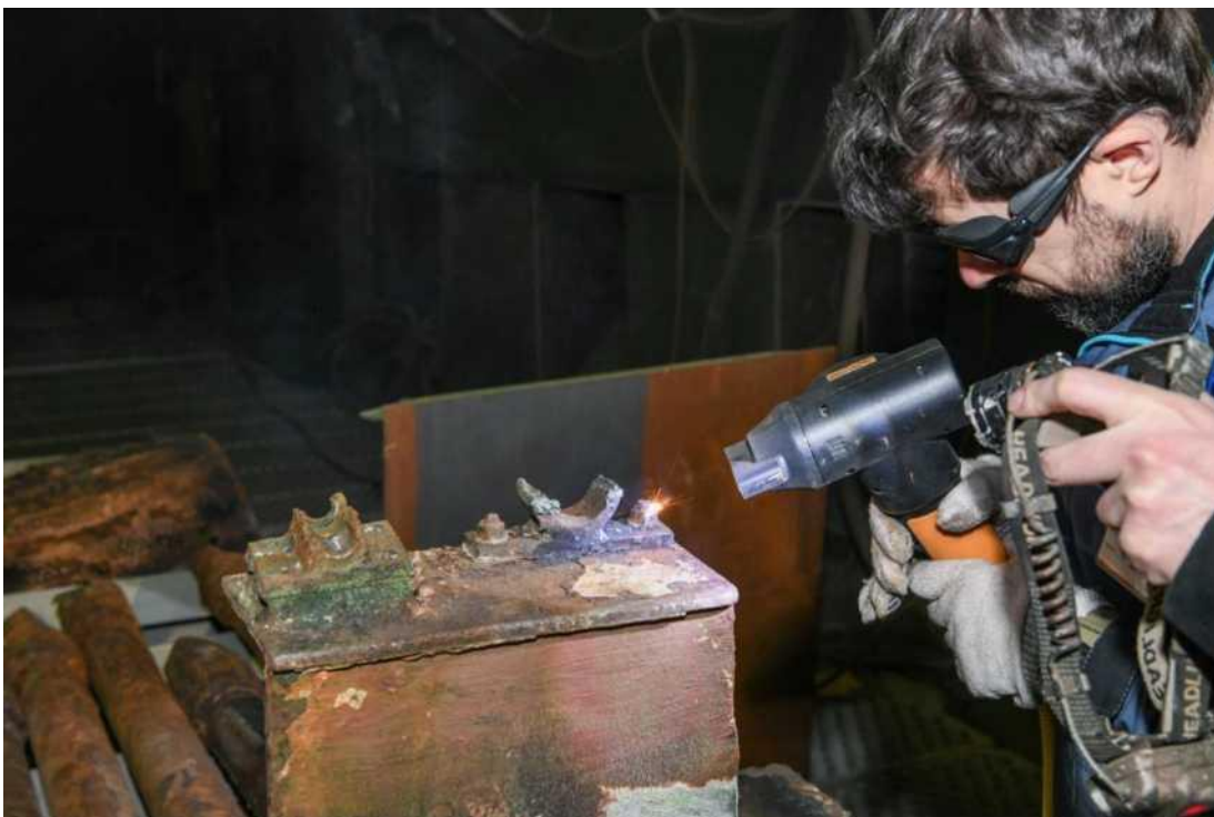
Фото 23. Сотрудник АО «АВК» осуществляет процесс обработки. Исходный образец - металлоконструкция. Материал СТЗ. Обрабатываемая поверхность - язвенная коррозия.
