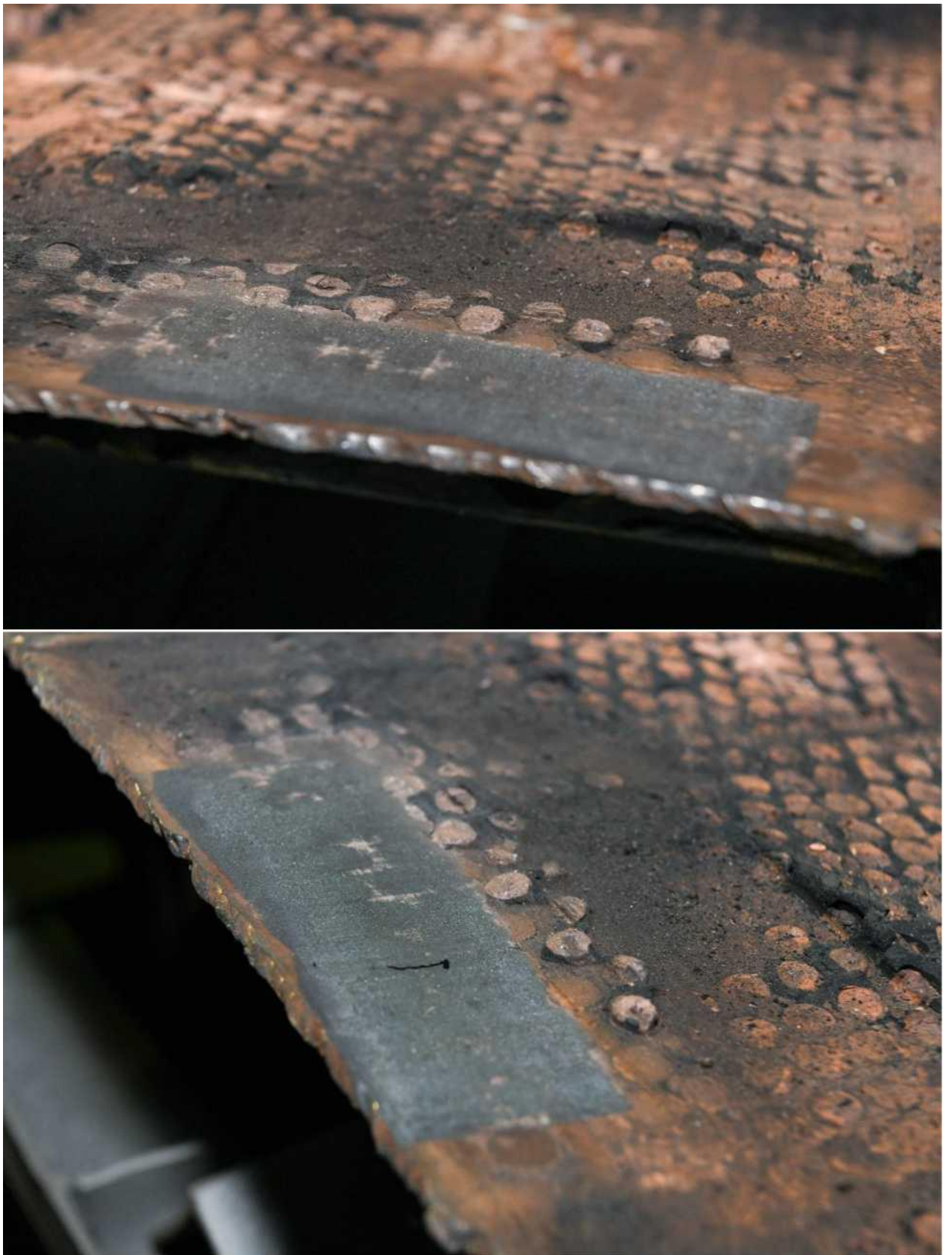
Фото 9. Результат очистки образца - Секция надстройки. Обрабатываемая поверхность - остатки спецпокрытия и ЛКП типа ЭП-0010 толщиной до 2500 мкм.
