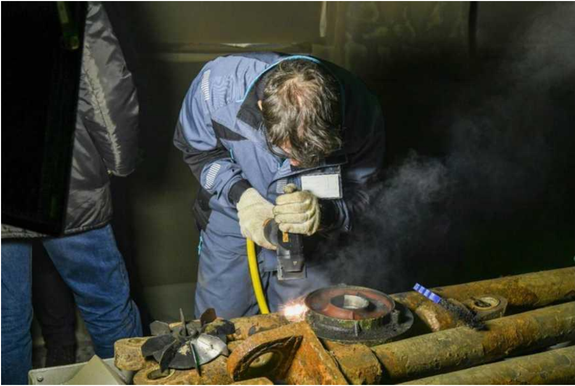
Фото 28. Сотрудник АО «АВК» осуществляет процесс обработки крышки электродвигателя с посадочным местом под подшипник, окрашенным ФЛ-03К в 1 слой. Обрабатываемая поверхность - масляные загрязнения.
