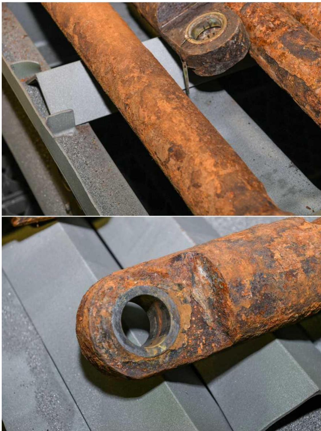
Фото 11. Исходное состояние образцов - Тяга привода. Обрабатываемая поверхность - латунные втулки, окалина, язвенная коррозия, остатки толстостенного ЛКП типа БЭП.
